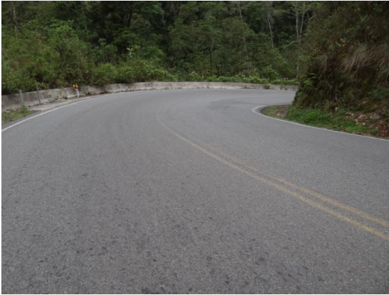
Fotografías 37 y 38. Tanto la línea de centro como la de borde se encuentran altamente desgastadas
