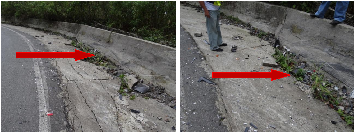
Fotografías 52 y 53. SCV, rígido, impactado delatando la salida de vehículos por exceso de velocidad
