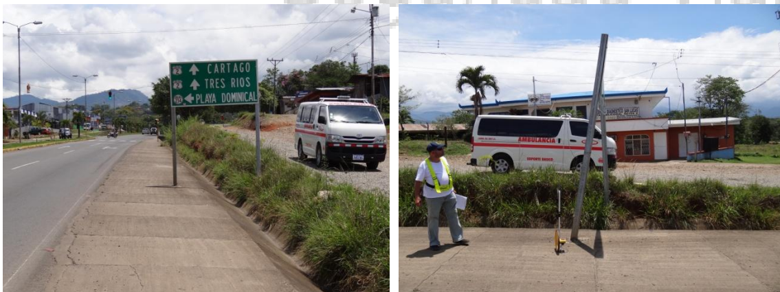
Fotografías 70 y 71. Señalamiento vertical colisionado
