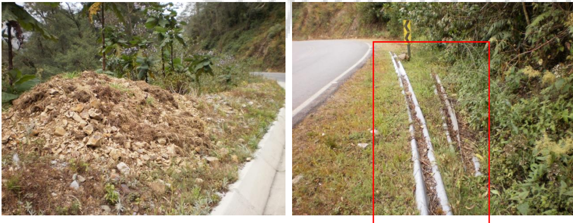
Fotografías 19 y 20. Trabajos de mantenimiento de la vía inhabilitan SCV
