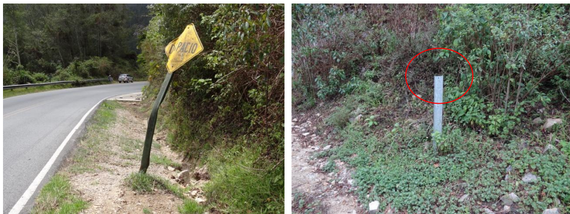
Fotografías 15 y 16. Señalamiento vertical en mal estado y presencia de vandalismo
