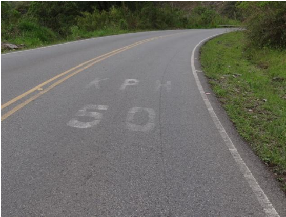
Fotografías 39 y 40. La demarcación de velocidad se encuentra poco visible para el flujo vehicular debido al desgaste y falta de mantenimiento
