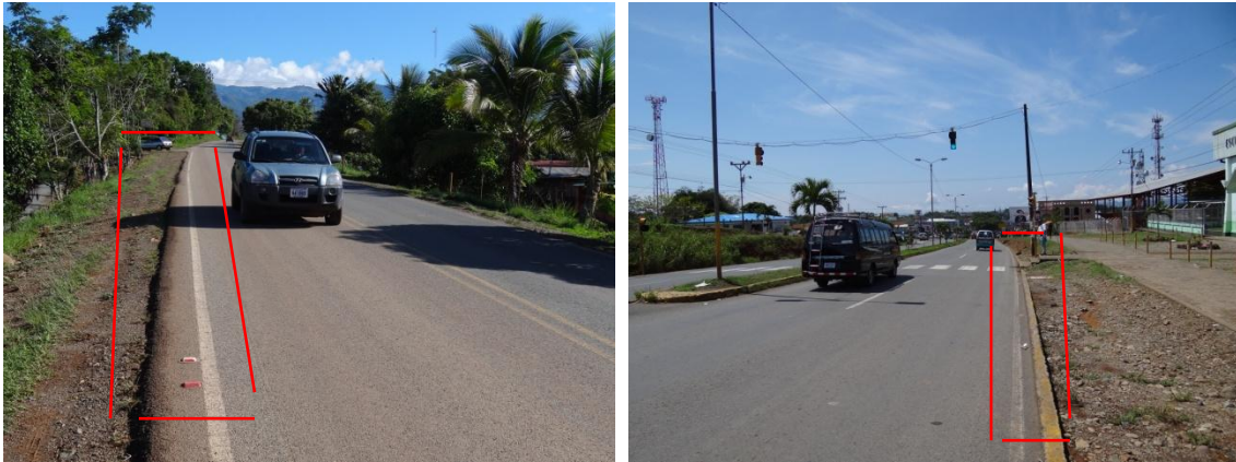
Fotografías 56 y 57. Ausencia de espaldón seguro continúa a lo largo del Km 133
