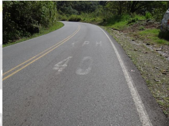
Fotografías 39 y 40. La demarcación de velocidad se encuentra poco visible para el flujo vehicular debido al desgaste y falta de mantenimiento
