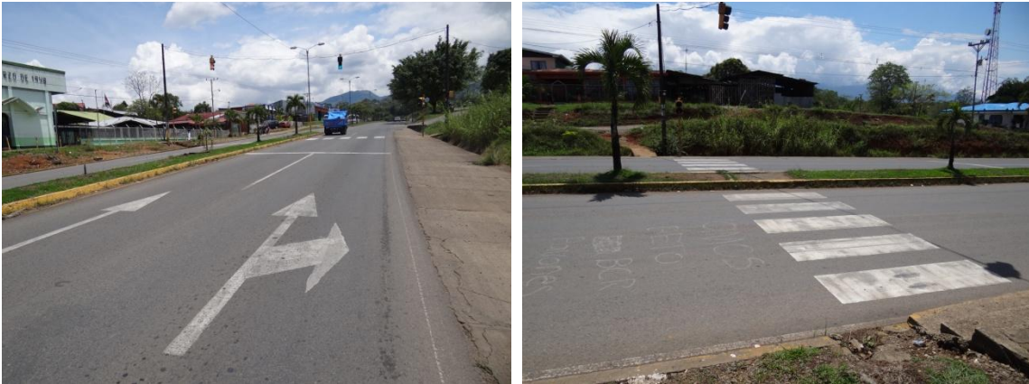
Fotografías 64 y 65. La retroreflectividad de la demarcación no es eficientemente visible para el flujo vehicular
