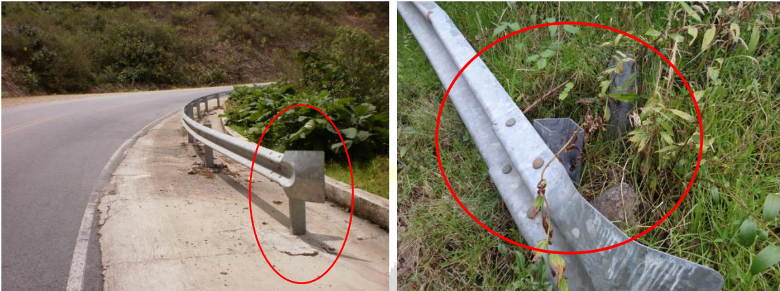
Fotografías 21 y 22. Terminales tipo cola de pez
