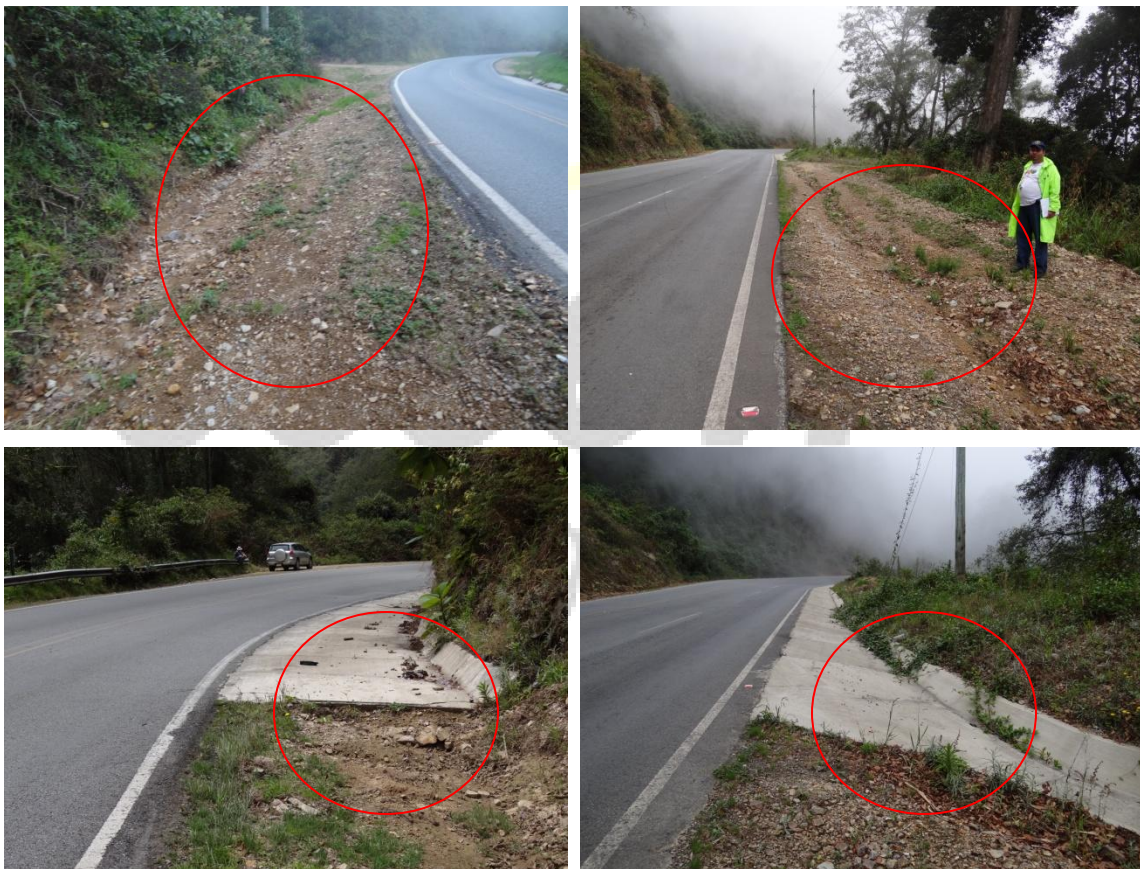
Fotografías 5, 6, 7 y 8. Detalle de la inconsistencia del drenaje sobre el Km. 102 de la Ruta Nacional N° 2
