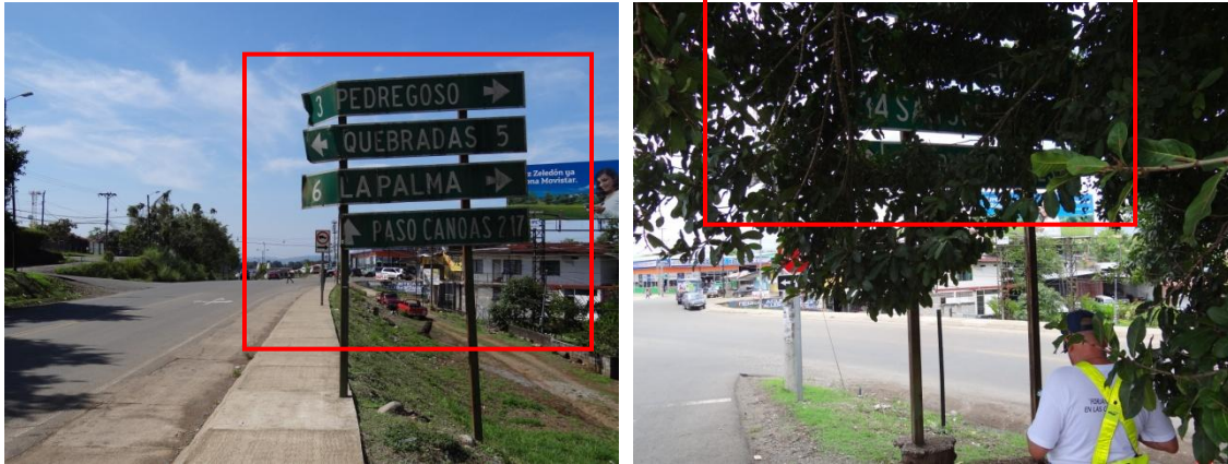
Fotografías 72 y 73. Presencia de vandalismo y bloqueo por vegetación
