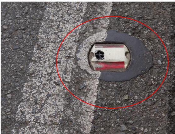
Fotografías 41 y 42. Los cataluces se encuentran irregulares a través de la vía, con el desprendimiento en algunas zonas, embebidos a la carpeta en otros y hasta algunos pegados con clavos
