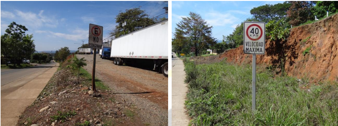
Fotografías 68 y 69. Señalamiento con ausencia de mantenimiento
