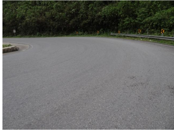
Fotografías 37 y 38. Tanto la línea de centro como la de borde se encuentran altamente desgastadas
