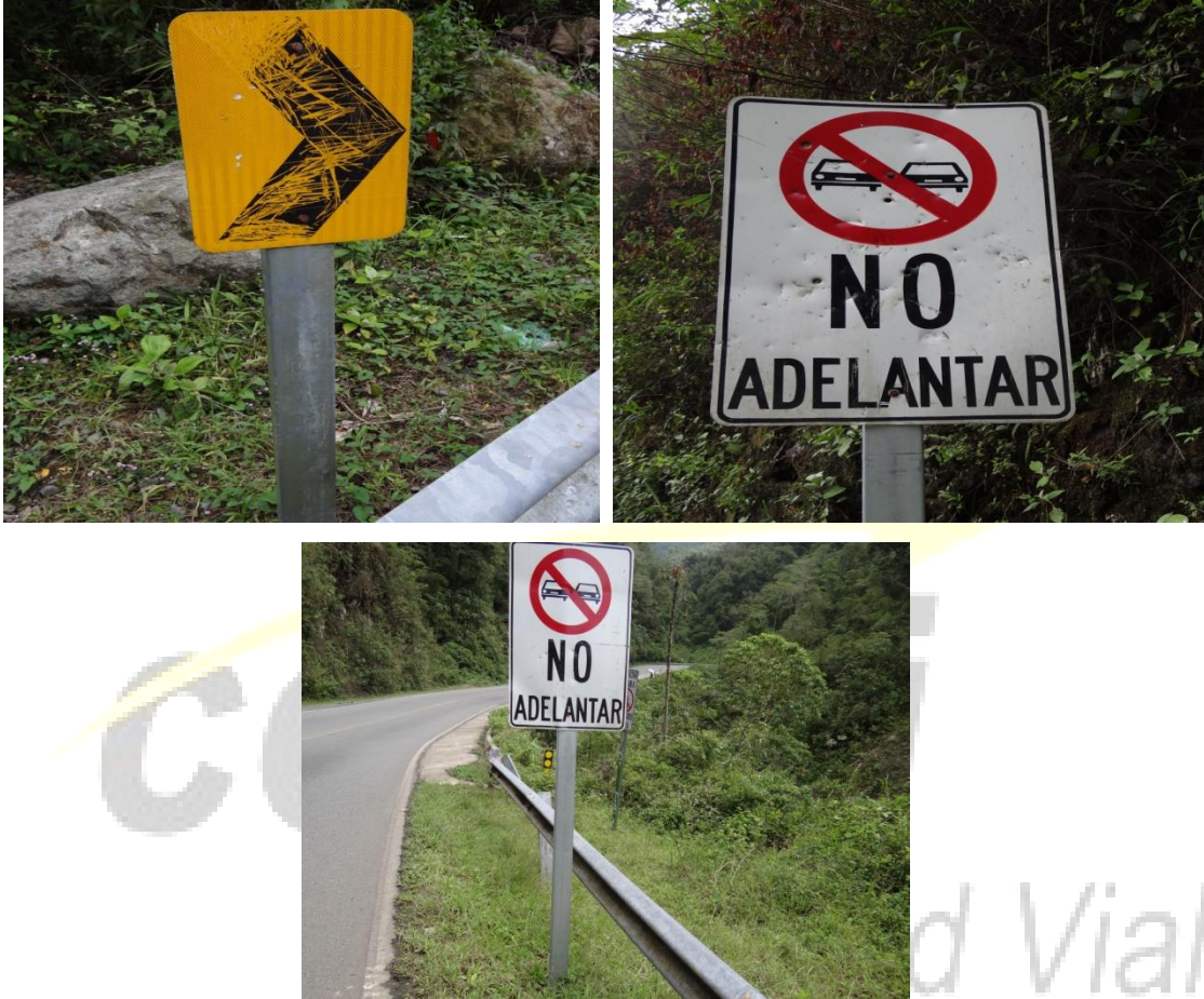
Fotografías 43, 44 y 45. Señalización vertical con presencia de vandalismo, se evidencia la falta de mantenimiento hacia las mismas, en ciertos tramos la colocación de las señales es incorrecta, como ejemplo la señal de NO ADELANTAR que se encuentra a mano izquierda del SCV, siendo su lugar a mano derecha
