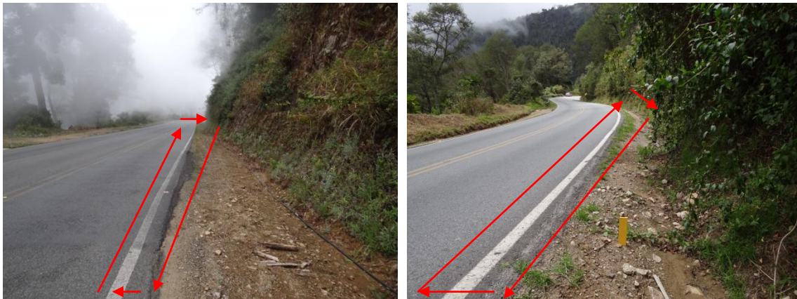
Fotografías 5 y 6. Diseño geométrico de la carretera no cuenta con espaldón seguro en ambos lados de la calzada
