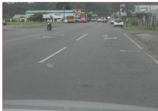
En la intersección Ruta 4 y la 505, la carpeta asfáltica se encuentra en estado regular, la demarcación horizontal (alto, línea de paro, flechas de dirección) se encuentran borrosas. No se evidencia línea de borde blanca a un lado de la carretera, se desconoce si esto es debido a que en los bordes de la calzada se encuentran deteriorados como lo muestran las imágenes. Se evidencian capitaluces.
