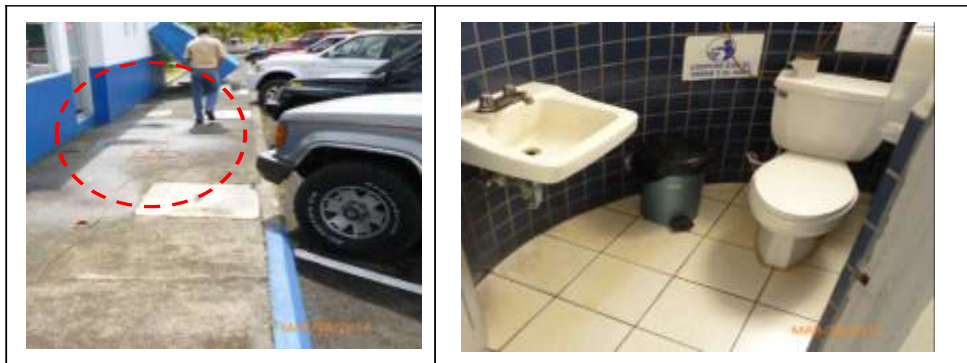
Fotografías 1 y 2. Localización de fuga en tubería de agua potable y servicio sanitario abierto al público aunque no había suministro de agua potable.
