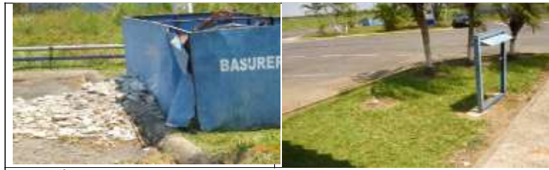
Fotografías 31-32 Basureros externos deteriorados.
