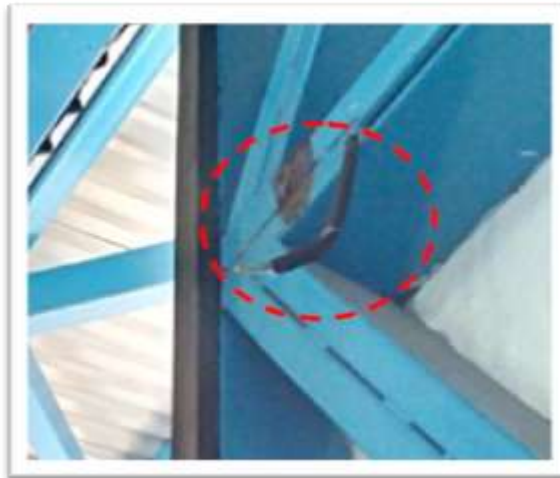
Cables Expuestos
