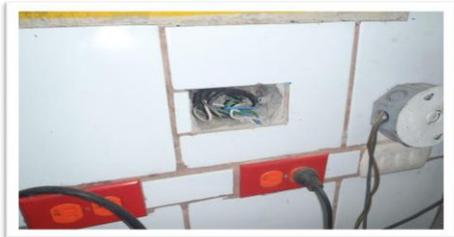
Cajas de conexión de cables con defectos de instalación en sus tapas.
