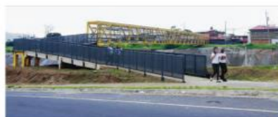
Infraestructura para peatones en rutas de alto riesgo
